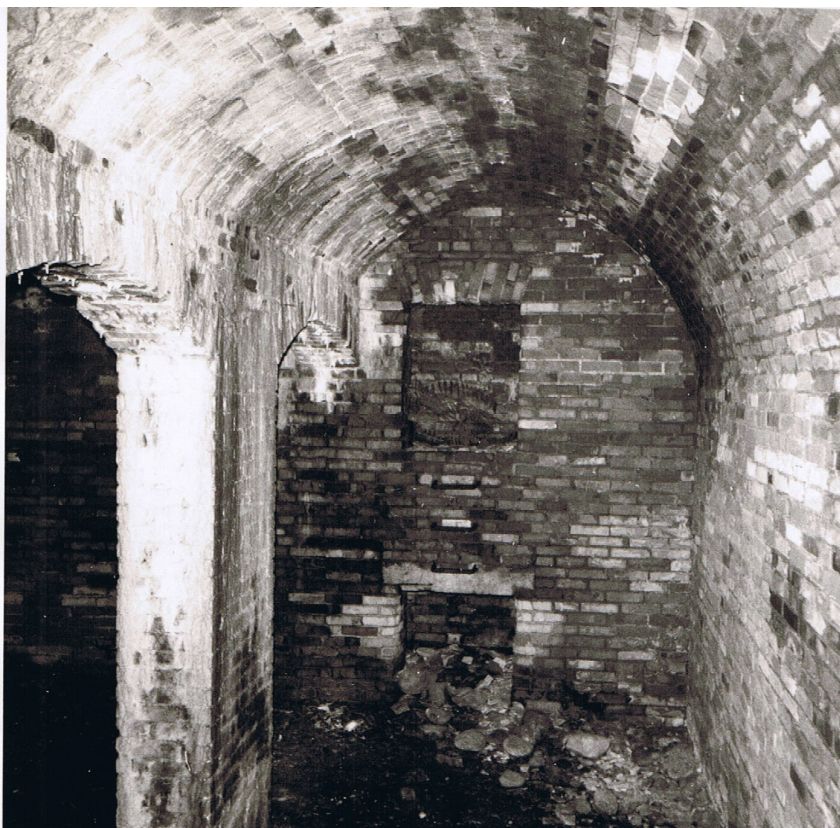
Ved kanonluftforsvarets stillinger var der opført bunkers i mursten. Bunkerne blev brugt til beskyttelse af mandskabet og opbevaring af ammunition. Bagerst er der et hul som man kan komme ud af, hvis bunkeren bliver ramt af en bombe. (Foto N.M. Schaiffel-Nielsen)
