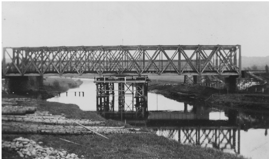
Foto fra museet i Langå. Broerne sank noget sammen efter sprængningerne 18. november. Gennem gitterbroerne ses kassebroen fra 1866, klar igen 30. november, mens de afstivede gitterbroer blev klar igen 17. december, også kun for langsom trafik.
