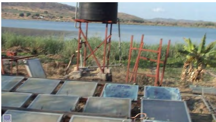
Her ses et anlæg til pasteurisering af drikkevand ved hjælp af solenergi. Anlæggene blev opfundet og udviklet af Kirsten sammen med medarbejdere ved Odense Tekniske Skole. Der blev opsat anlæg til ca. 20 000 mennesker i 7 landsbyer ved Tanganyikasøen. Landsbyer, der alle for nyligt havde haft koleraepidemier.
