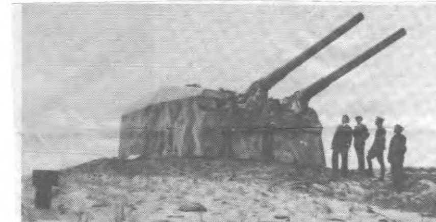
Det kneb at skaffe effektivt materiel til de jyske befæstninger, men efterhånden som den tyske højse-flådes betydning mindskedes og de store enheder blev sænket eller indespærret i havnene i Europa, blev deres svære kanoner afmonteret og flyttet til først og fremmest de jyske befæstningsanlæg. Her er det et sæt svære tvillingkanoner fra slagkrydseren »Gneisenau«, der opstilledes nord for Esbjerg.
